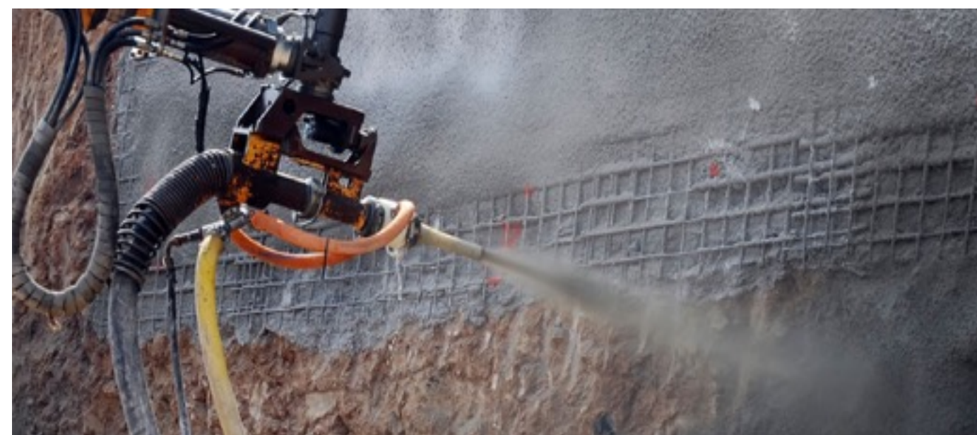
Роботизированное торкретирование
