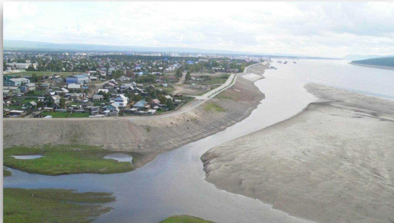
Недостатками систем с дамбами обвалования являются: высокая стоимость сооружений из-за значительной длины дамб; необходимость устройства на защищаемой территории дренажных систем для сбора фильтрующей через дамбы воды и насосов для ее откачки, большие эксплуатационные издержки.
