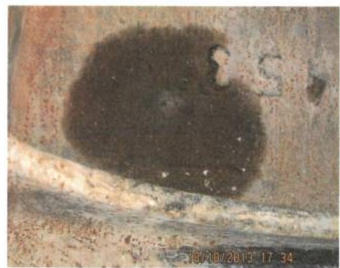
Рис. 3.5— Водопроявления в виде «мокрых» пятен
