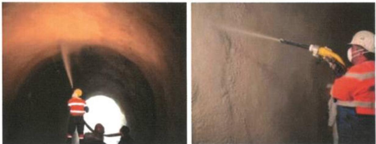
Рисунок 9.4 Технология нанесения напыляемой гидроизоляции на подготовленную поверхность ручным способом.
